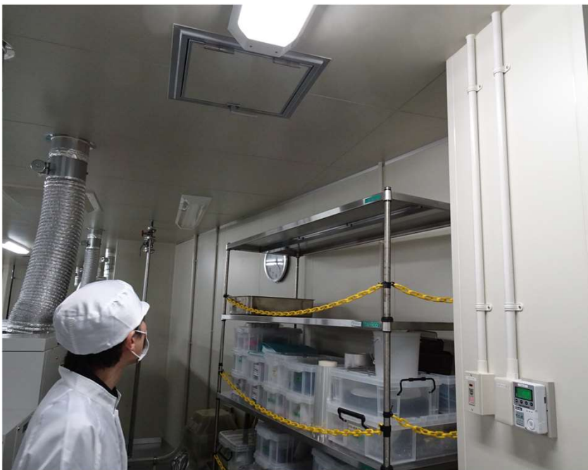
安全衛生パトロール風景
