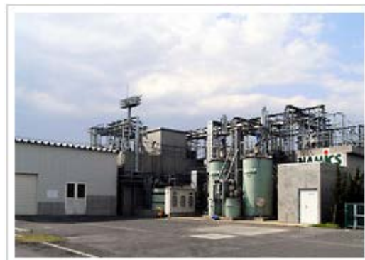
排水処理施設(本社工場)
