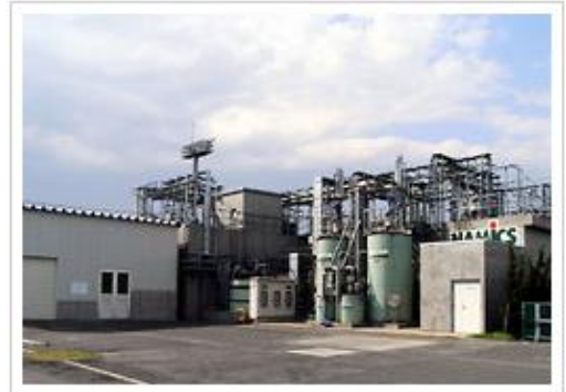
排水処理施設(本社工場)
